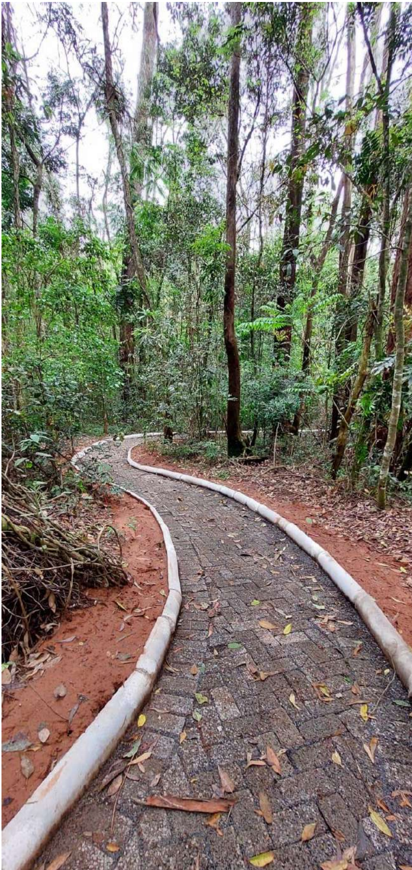
Trilha Inclusiva – Obra
