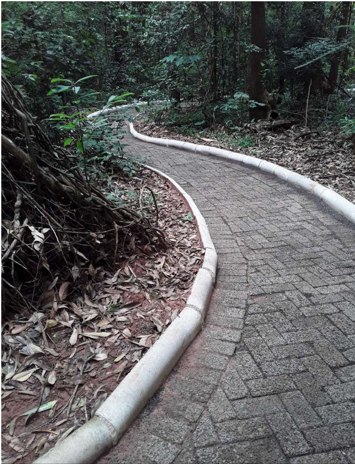
Trilha Inclusiva – Obra Finalizada
