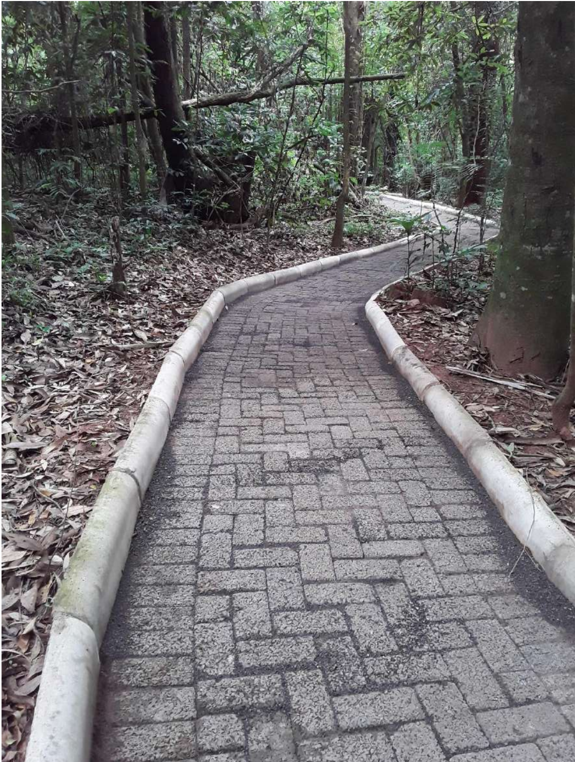
Trilha Inclusiva – Obra Finalizada
