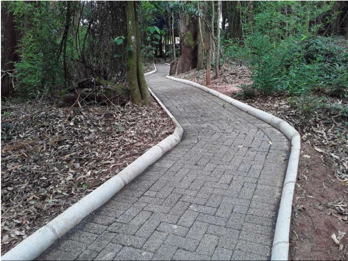
Trilha Inclusiva – Obra Finalizada
