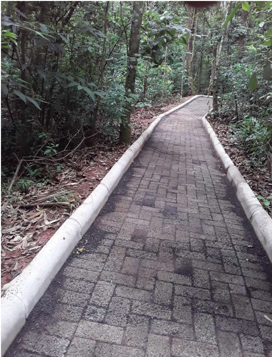
Trilha Inclusiva – Obra Finalizada
