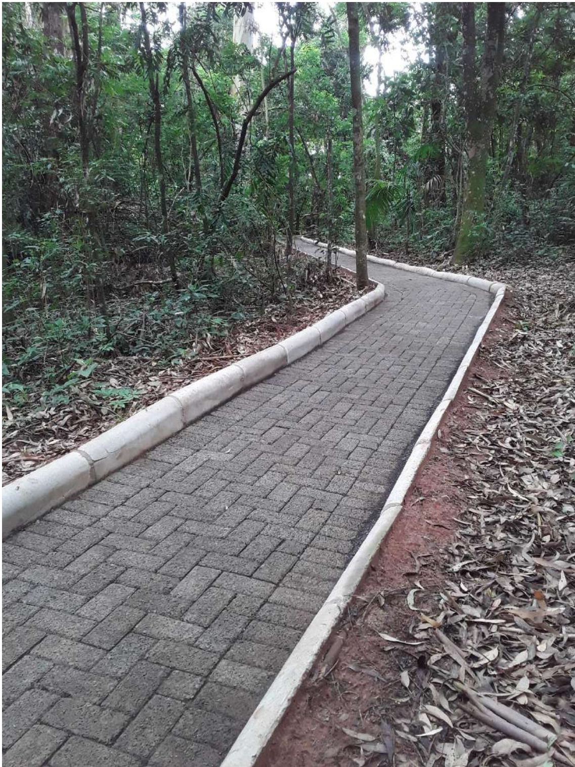
Trilha Inclusiva – Obra Finalizada
