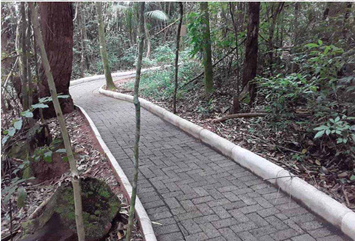
Trilha Inclusiva – Obra Finalizada
