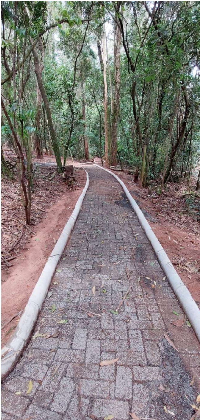
Trilha Inclusiva – Obra Finalizada
