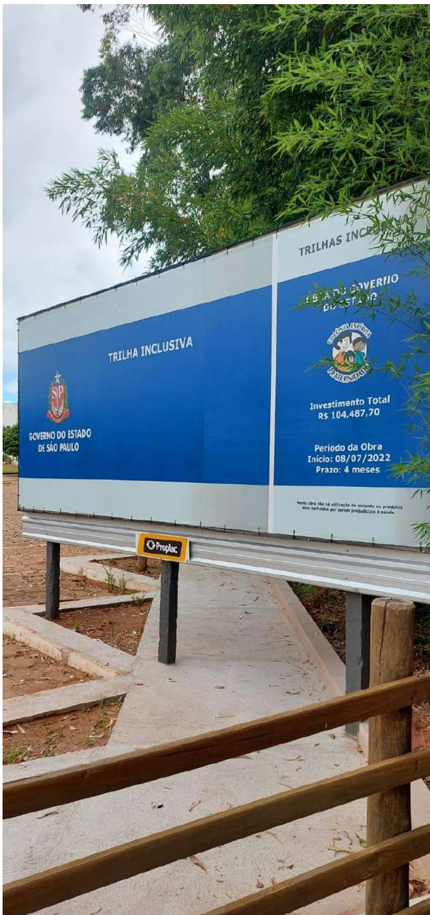
Placa da Obra – Trilha Inclusiva
